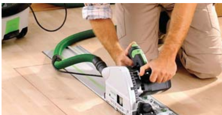
Ist die Schnitttiefe millimetergenau eingestellt, kann man mit einer Tauchsäge samt Führungsschiene beschädigte Parkett- oder Laminatdielen heraus sägen ohne dass das Sägeblatt den Betonestrich berührt. Die Führungspräzision der Schiene sorgt dabei für eine perfekte und nahezu unsichtbare Reparatur.
